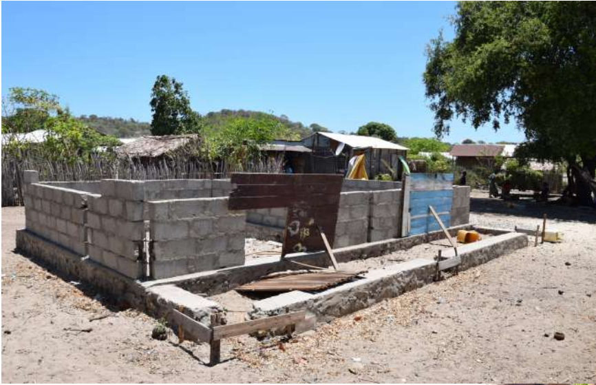
Chantier de la cantine, à poursuivre
