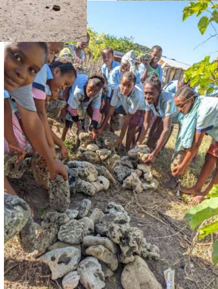
Recherche de cailloux par les collégiens et leur professeur Bahjah pour les fondations de la future cantine
